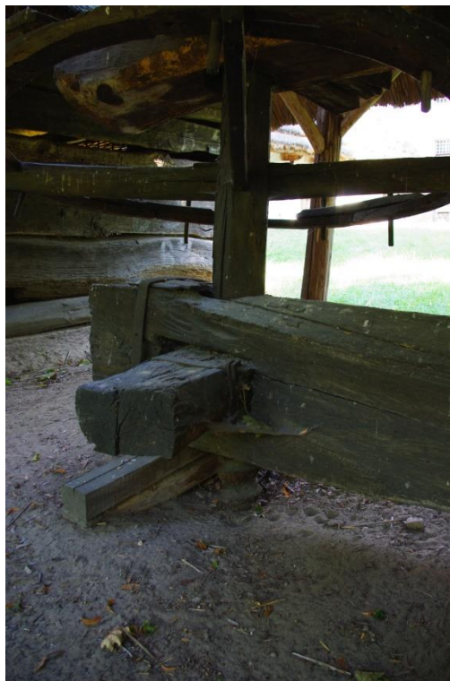
Spirális tengely, kerék és az alsó tengelyrögzítő fa
